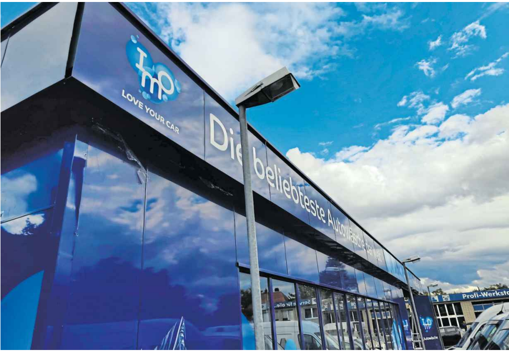
Die Waschanlage an der Lütmarser Straße 66a in Höxter wird erneuert.
