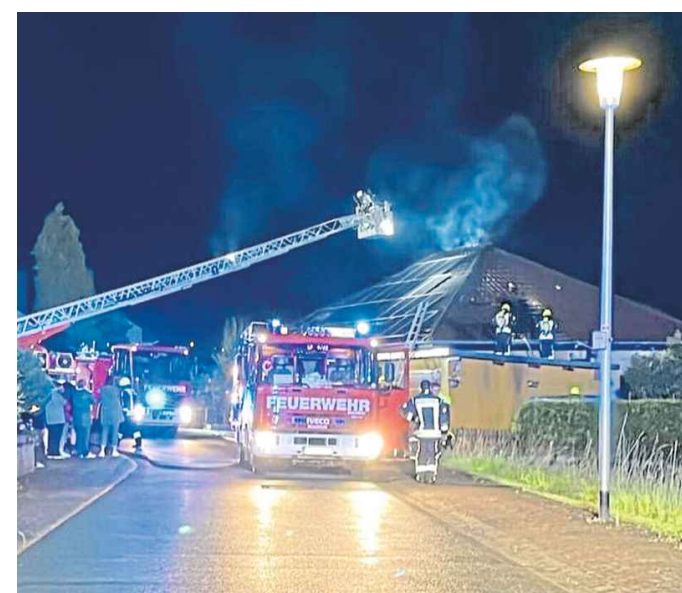
Ein Dachstuhlbrand fordert nach dem Gewitter in der Nacht zu Mittwoch die Einsatzkräfte.
