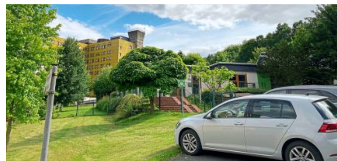
Die Kindertagesstätte „Rappelkiste“ am St. Ansgar-Krankenhaus ist seit Ende 2023 Baustelle. Ein großflächiger Wasserschaden muss beseitigt werden. Foto: Maïke Robrecht
