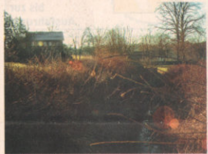
Der Mühlengraben mit der alten Mühle - die Wasserleitung der Nonnen.
