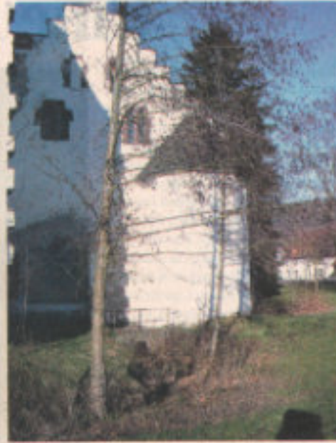
Das Wasser floss durch die Küche und trat an der Kloake wieder aus.
